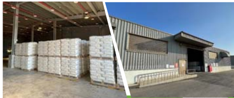
硝酸銨堆垛、保留通道空間 維持通風、照明、有消防通報、應變設備
