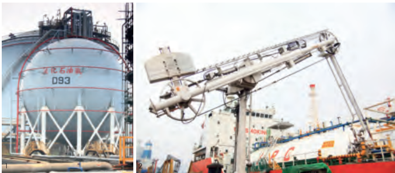
1. 大林廠內用來儲存LPG的球形高壓常溫儲存槽。2. 大林廠LPG球型高壓常溫儲存槽經由卸料臂將LPG輸送到出口船舶上高壓常溫儲存槽。
