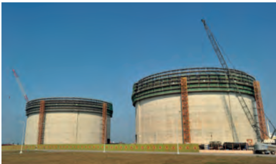
台中廠目前正進行增建3座16萬公秉地上式儲槽及附屬設施作業。
