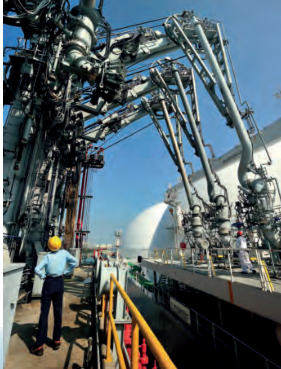
LNG船靠泊至卸收碼頭後，由船上泵浦將LNG泵送出，經碼頭卸料臂輸往儲槽儲存。
