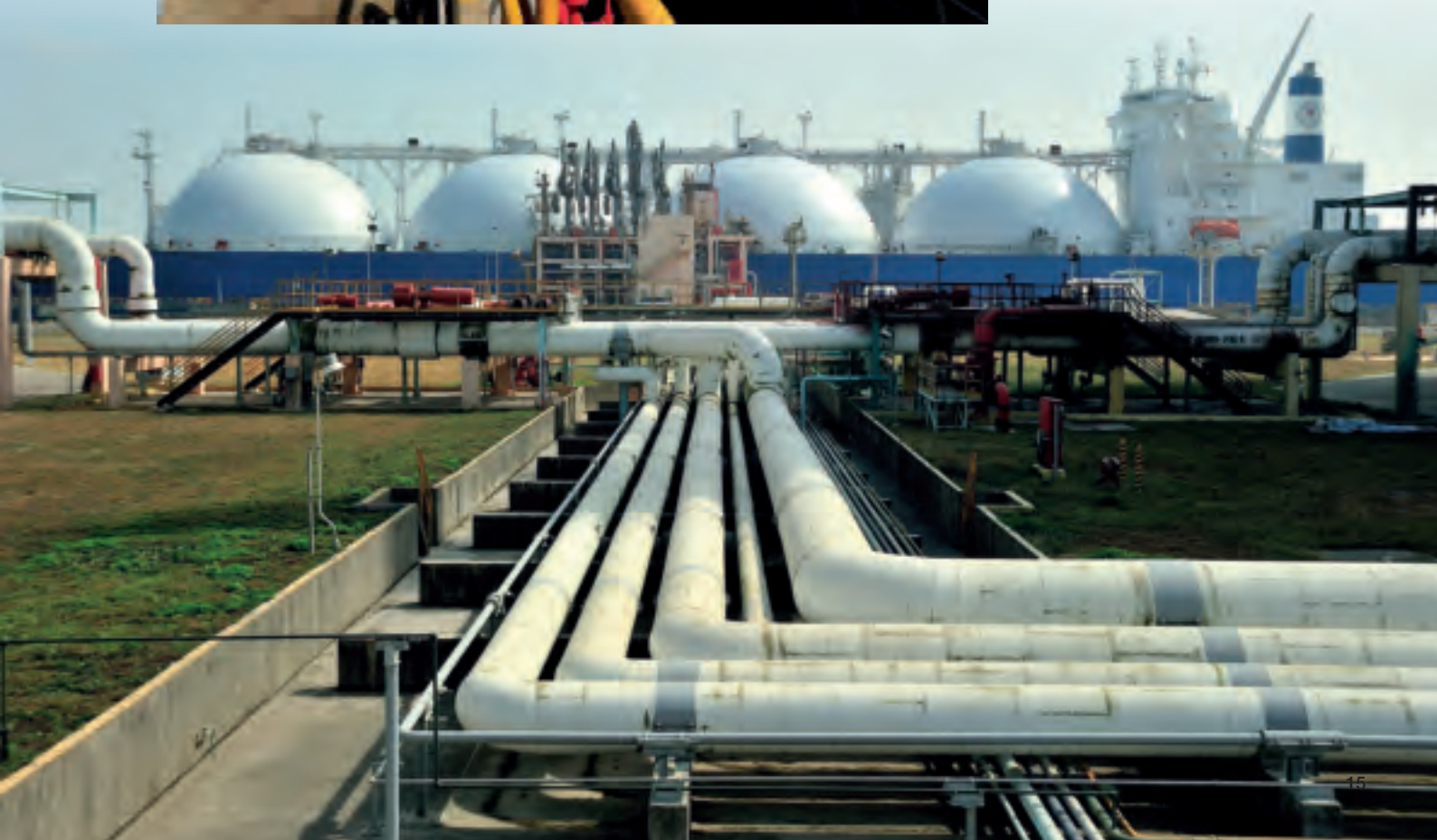
LNG船靠泊至卸收碼頭後，由船上泵浦將LNG泵送出，經碼頭卸料臂輸往儲槽儲存。
